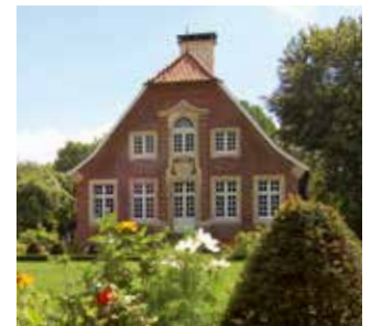
Haus Rüschaus: Gartenansicht
