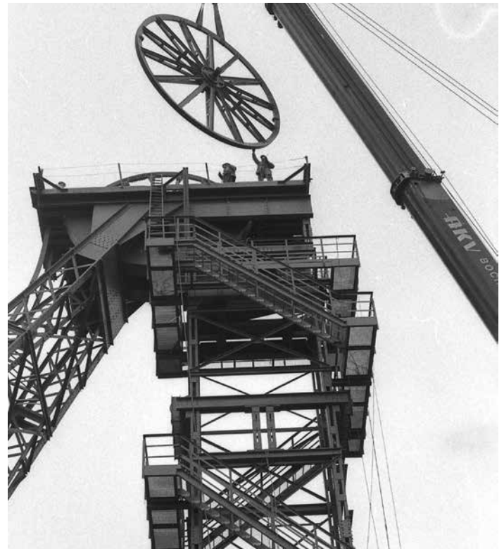
Die Zeche Zollern als Ort des Wandels in der Ausstellung „RevierGestalten“ : Einsetzen der Seilscheibe in das Fördergerüst über Schacht IV im Februar 1988
