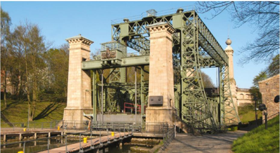
Das Schiffs-Hebe-Werk funktionierte wie ein **großer Aufzug**.
